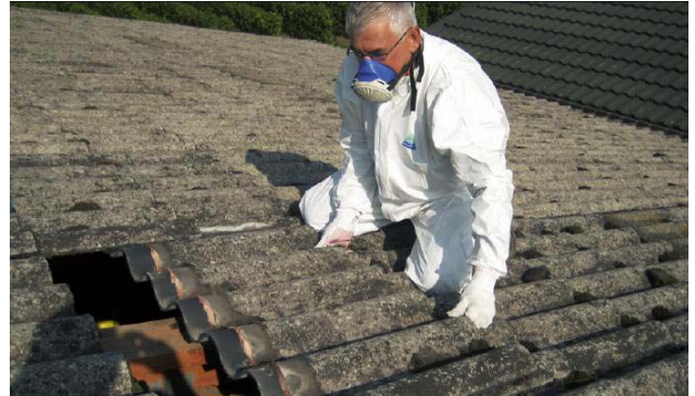
Abb. Rückbau eines Asbestzement-Daches
