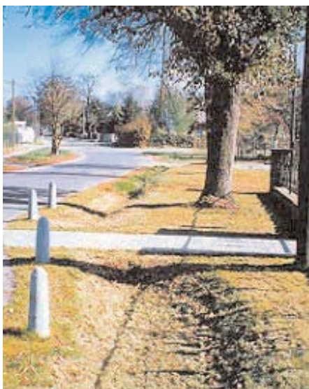
Abb. 12 Mulden-Rigolen-Systeme an einer Straße
